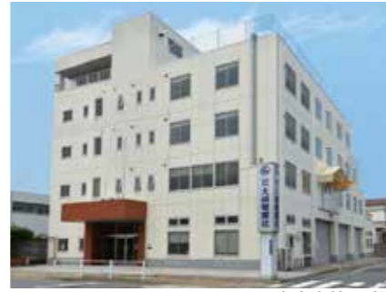
東京本社・工場
