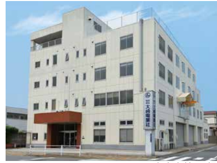
東京本社・工場
